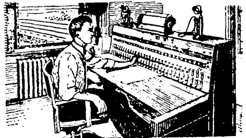
Рис. 1. Ж.-д. диспетчер на участке Стенлей-Бервик (США). Нажатием рычажков на центральном аппарате диспетчер на значительном расстоянии управляет положением электрифицированных стрелок и входных сигналов на главных путях, подчиненного ему участка. В верхней части диспетчерского аппарата находится табло (изображающее ж.-д. путь и станции), на к-ром автоматическим образом изображается движение поездов, положение стрелок и сигналов.
